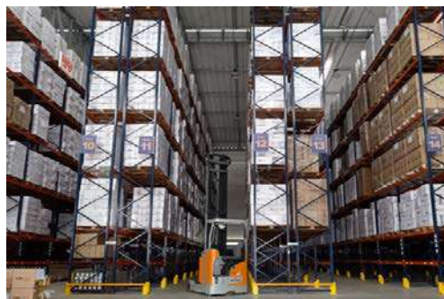
Centro de Distribuição Itajaí - SC
